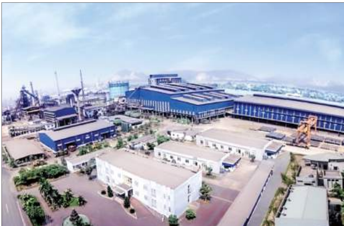
Công ty cổ phần thép Hòa Phát Hải Dương, phường Hiệp Sơn, thị xã Kinh Môn, tỉnh Hải Dương
