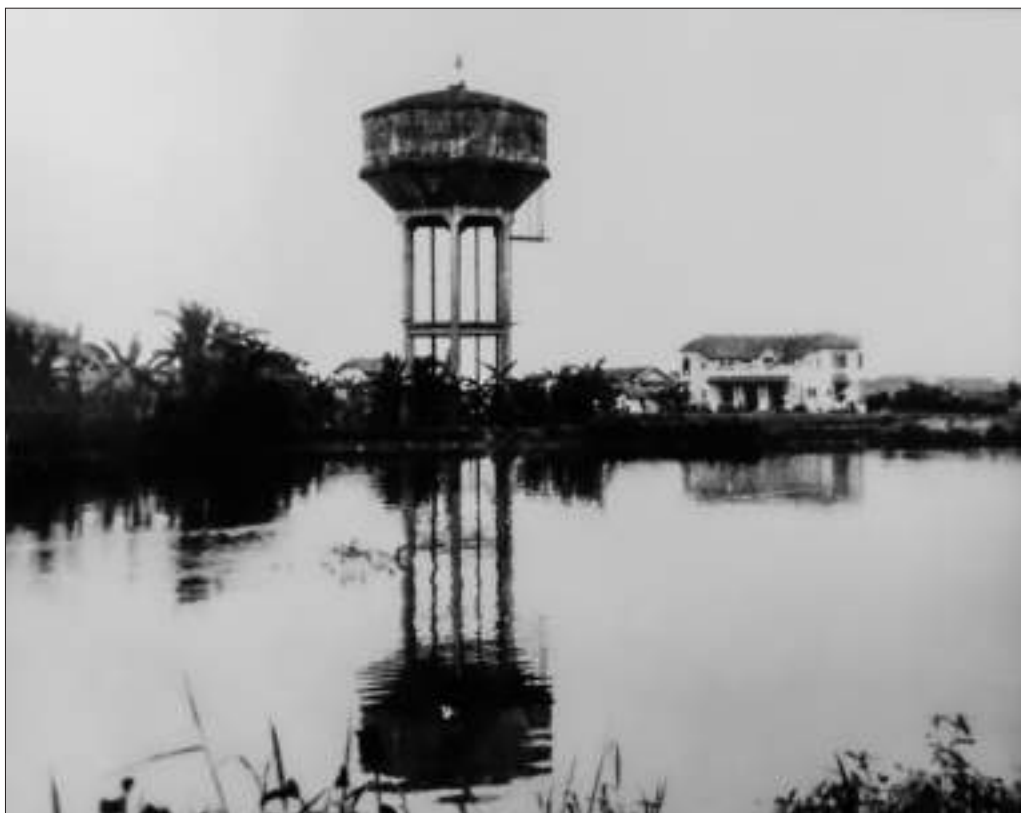
Tháp nước ở thành phố Hải Dương, nơi cơ sở cách mạng cắm cờ kỷ niệm Cách mạng Tháng Mười Nga năm 1940
